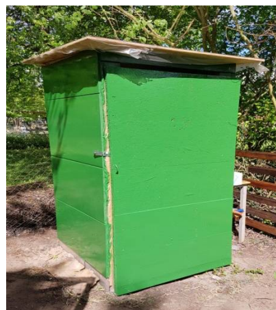
Bild 3 – Das fertige Toilettenhäuschen
