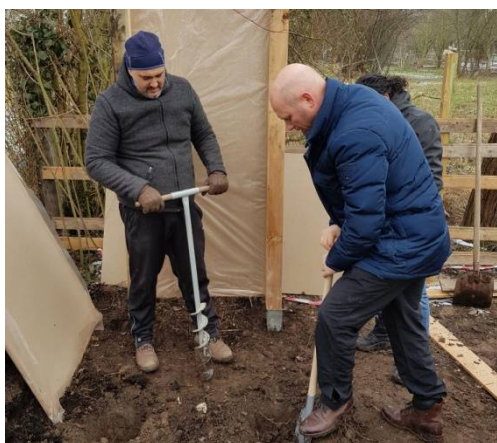
Bild 2 – Väter beim Bau der Komposttoilette
