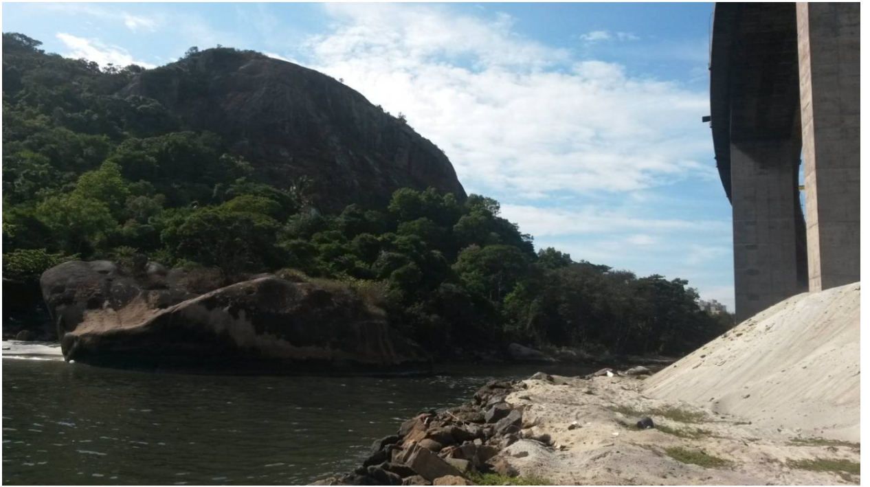
Устье канала Коста. Вид скалы на разрушение с левого берега канала
